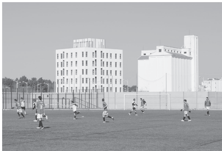
13. Rosana PÉREZ GONZÁLEZ: Edificio en bloque aislado de 15 viviendas , Albacete, 2013. Vista exterior junto al silo.
