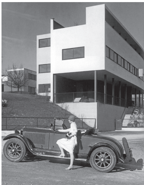
9. LE CORBUSIER: Casa doble en la Weissenhofsiedlung , Stuttgart, 1926-1927. Vista exterior.
