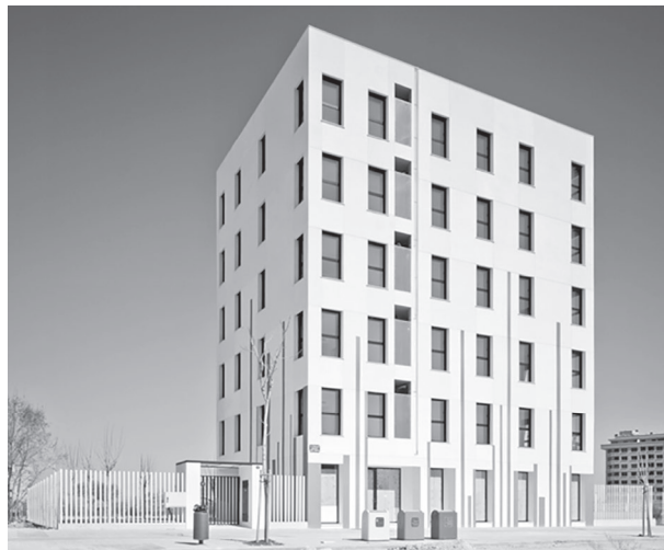
16. Rosana PÉREZ GONZÁLEZ: Edificio en bloque aislado de 15 viviendas , Albacete, 2013. Vista exterior.
